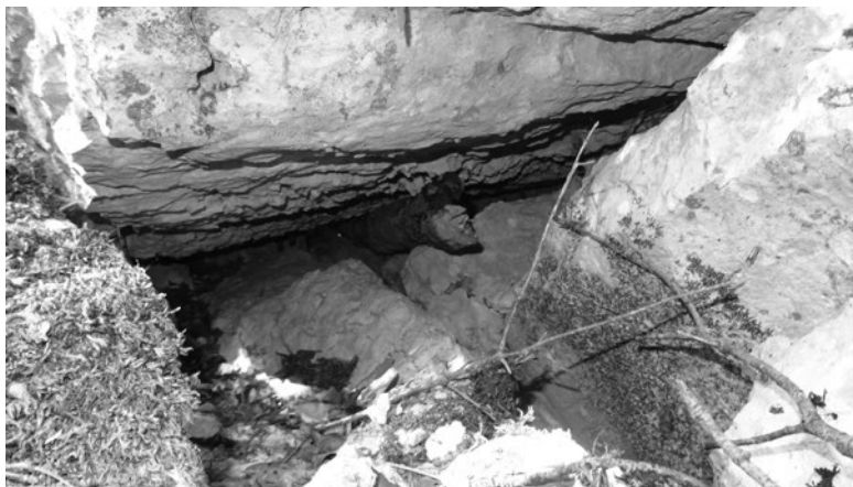
Sl. 5. Oblica ispod kamenoga bloka u Kljenku (foto; I. Alduk)
