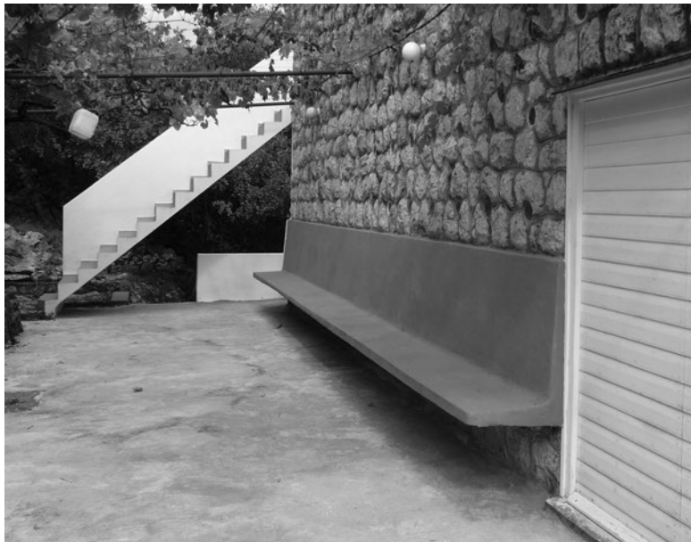
Sl. 9. Nikola Dobrović, Vila Vesna na Lopudu (1937. – 1940.), južna fasada (foto: A. Baće)
