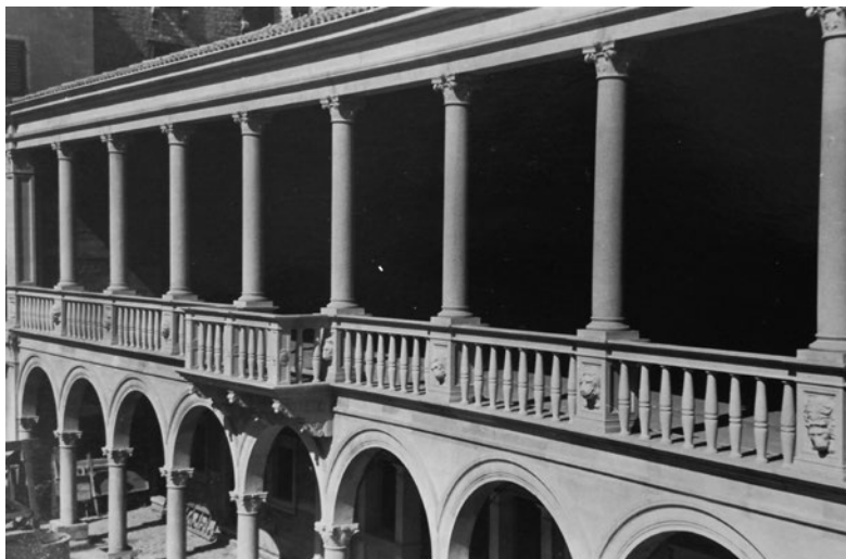
Sl. 6. Nepoznati snimatelj, Radovi na šibenskoj Loži 1951., Dovršetak izgradnje oplošja, Državni arhiv u Šibeniku-272, OAF F. Dujmović, bez broja.
