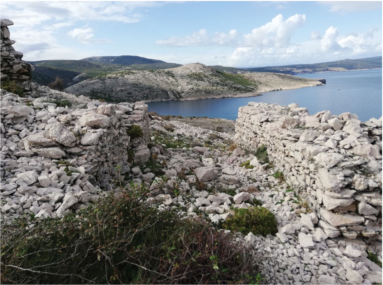
Slika 7: Pogled iz utvrde Veli grad kroz ulaz u smjeru zapada (foto: D. Branković)
