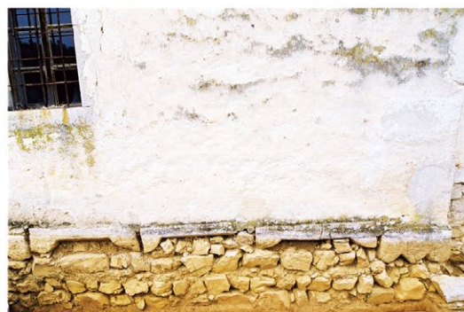
6. Segment južnog pročelja
