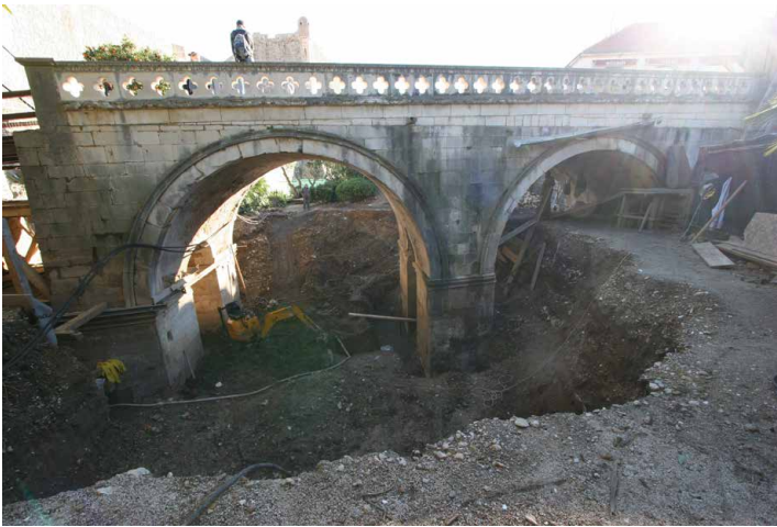
Sl. 67. Pogled na otkopane pilone, most od Pila u Dubrovniku (foto N. Topić, Omega engineering d.o.o. Dubrovnik)
