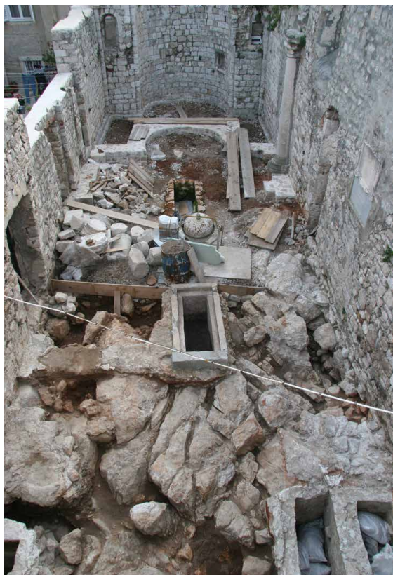
Sl. 30. Pogled na unutrašnjost crkve sv. Stjepana u Dubrovniku (foto I. Radić, B. Doljanin, Omega engineering d.o.o. Dubrovnik)
