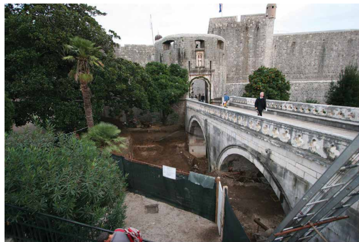
Sl. 64. Pogled na most od Pila u Dubrovniku (Z-I), 2014. (foto N. Topić, Omega engineering d.o.o. Dubrovnik)
