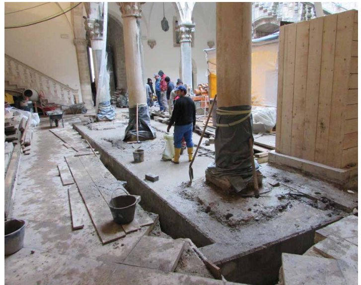
Sl. 62. Pogled na južne stupove i temelje, te recentne betonske strukture u atriju Kneževa dvora u Dubrovniku (JI-SZ) (foto N. Topić, Zavod za obnovu Dubrovnika)
