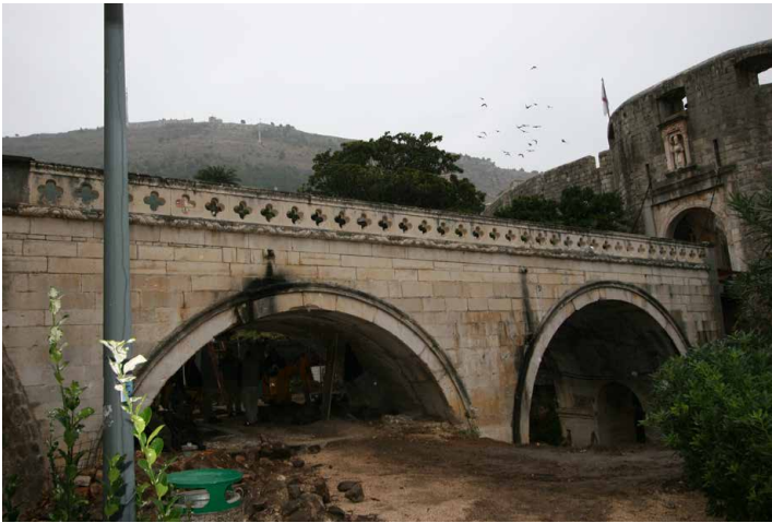
Sl. 65. Pogled na most od Pila u Dubrovniku, 2014. (foto N. Topić, Omega engineering d.o.o. Dubrovnik)
