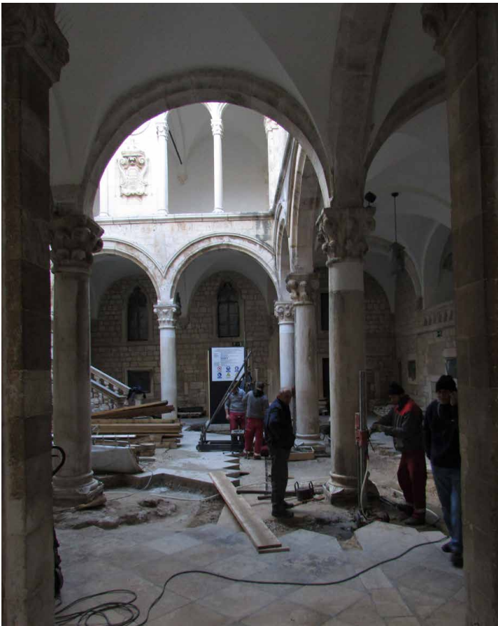
Sl. 61. Radovi u atriju Kneževa dvora u Dubrovniku 2015./2016. tijekom arheološkog nadzora (foto N. Topić, Zavod za obnovu Dubrovnika)
