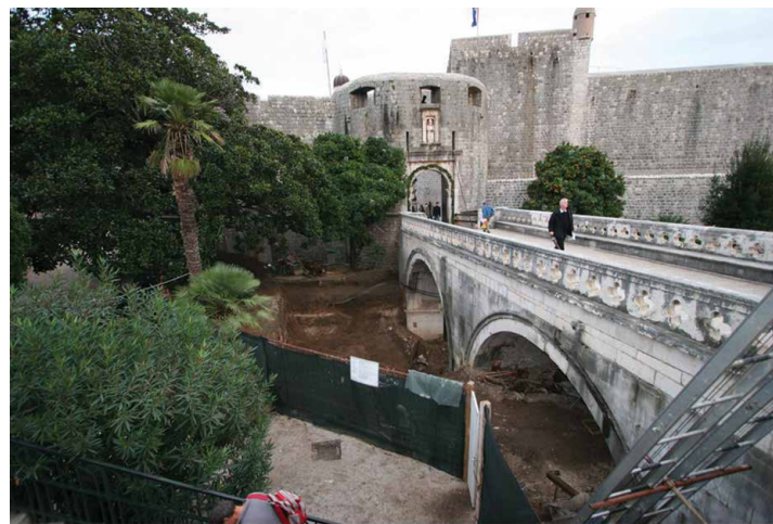
Sl. 64. Pogled na most od Pila u Dubrovniku (Z-I), 2014. (foto N. Topić, Omega engineering d.o.o. Dubrovnik)
