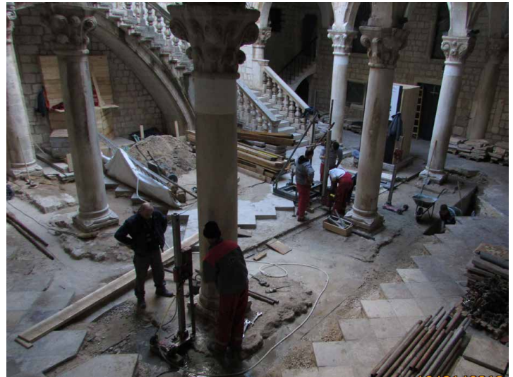
Sl. 60. Radovi u atriju Kneževa dvora u Dubrovniku 2015./2016. tijekom arheološkog nadzora (foto N. Topić, Zavod za obnovu Dubrovnika)
