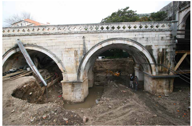
Sl. 68. Pogled na otkopane pilone, most od Pila u Dubrovniku (foto N. Topić, Omega engineering d.o.o. Dubrovnik)
