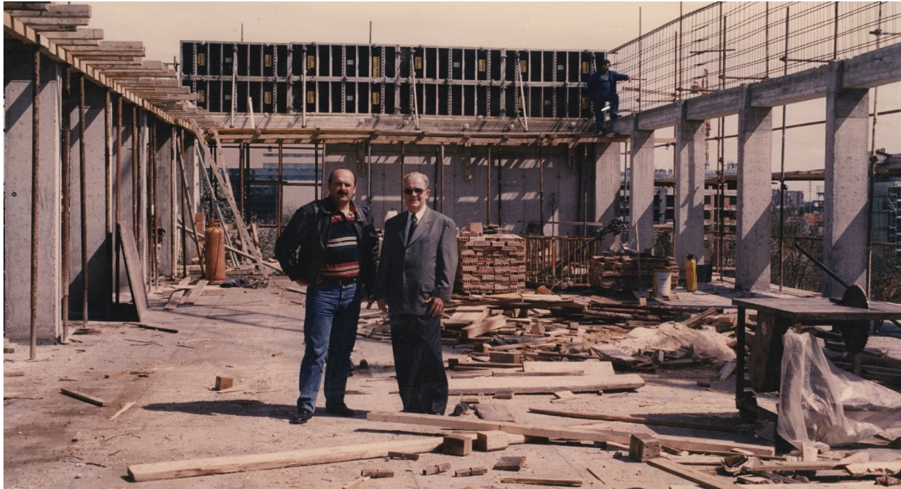
Izgradnja trećega kata zgrade Filozofskoga fakulteta započeta 1996. Na fotografiji desno tadašnji prodekan Nikša Stančić. Izvor: Arhiv Filozofskoga fakulteta.
