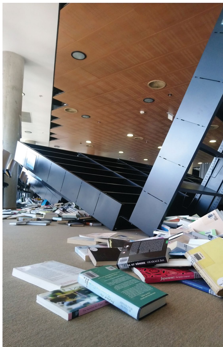
Oštećenja u Knjižnici nakon potresa 2020.
