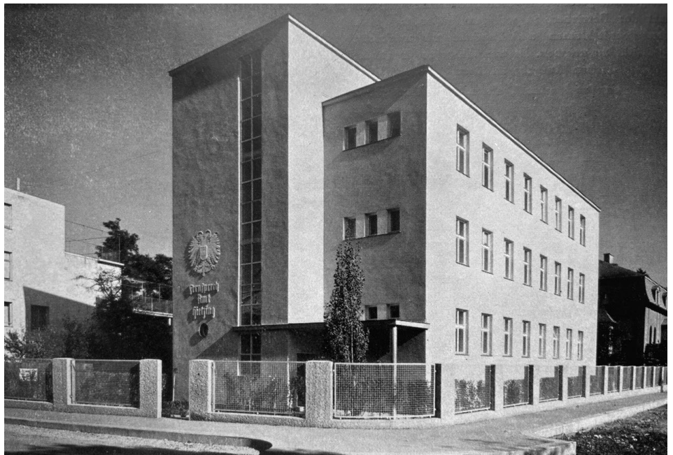
Fig. 9. Leopold Hoheisel, Telephon Exchange Office, Vienna, 1934, in: Österreichische Kunst , no. 11 (1935), 12.
