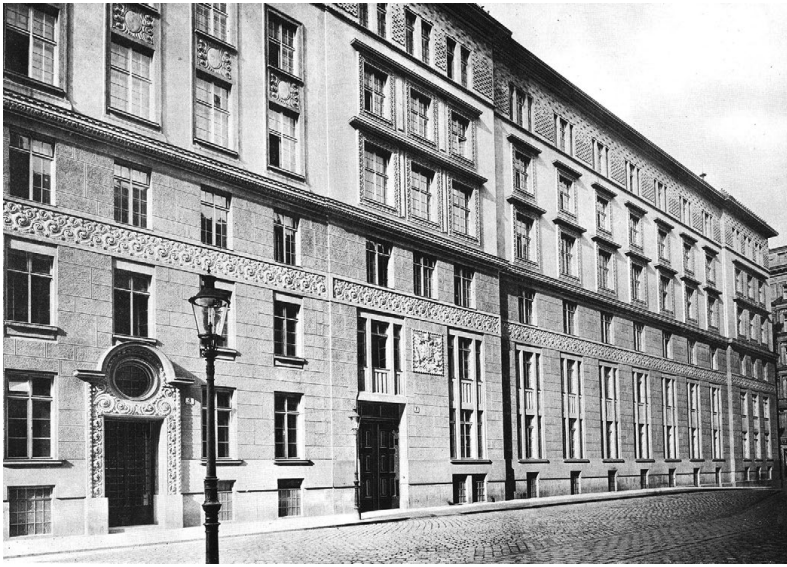
Fig. 5. Moritz Kramsall and Alfred Keller, Courthouse in Riemergasse, Vienna, ca. 1910, in: Allgemeine Bauzeitung , no. 78 (1913), plate 72, Austrian National Library, Vienna.
