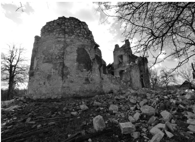
Sl. 13. Crkva svetog Đorđa u Jošavici nakon urušavanja u potresu od 29. 12. 2021. (foto: D. Damjanović, 4. II. 2021.)
