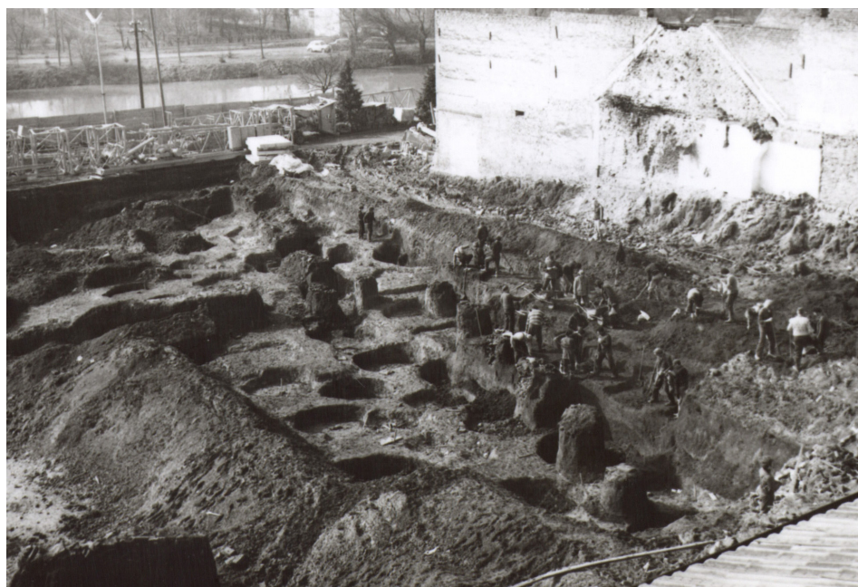
Slika 1.15. Ukopani objekti u zapadnome dijelu iskopa (fototeka GMV-k-a)
