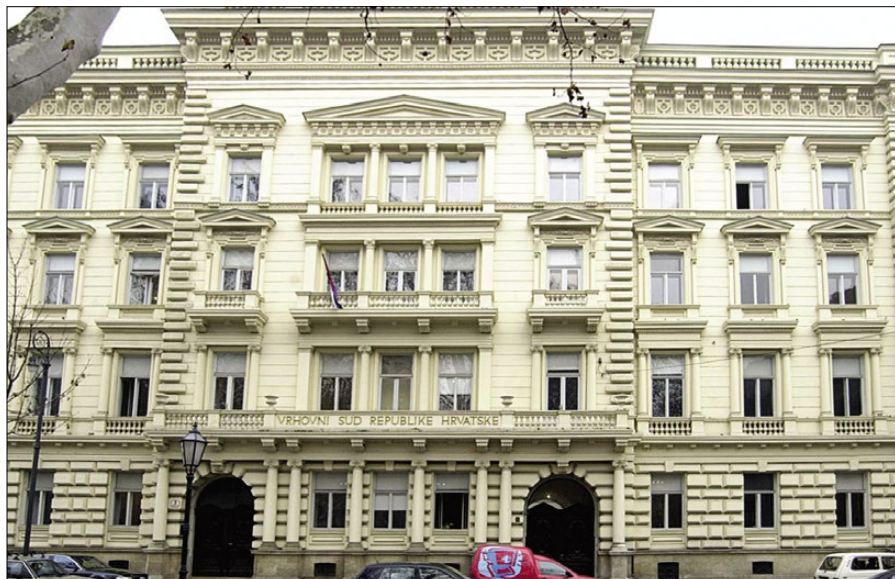
Zgrada Vrhovnoga suda RH
