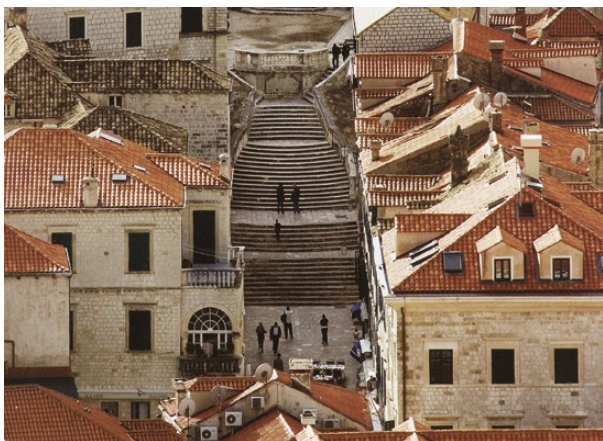
Sl. 69 Dubrovnik, stubište prema isusovačkom kolegiju
