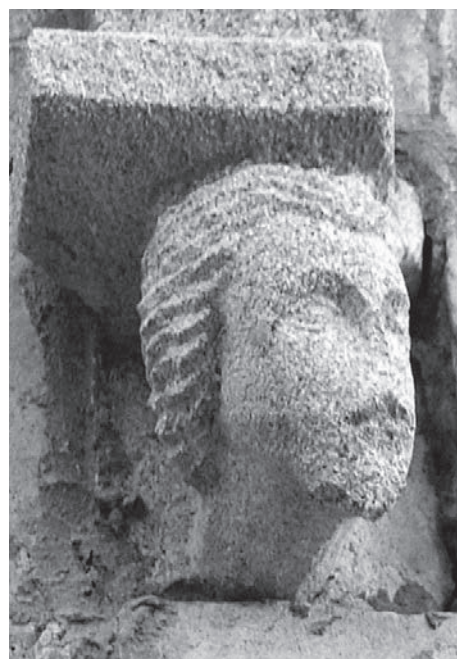
Fig. 7. Testa, dettaglio sul lato sinistro della trifora sul Piccolo Palazzo Cippico a Traù (Foto: M. Mijić)
