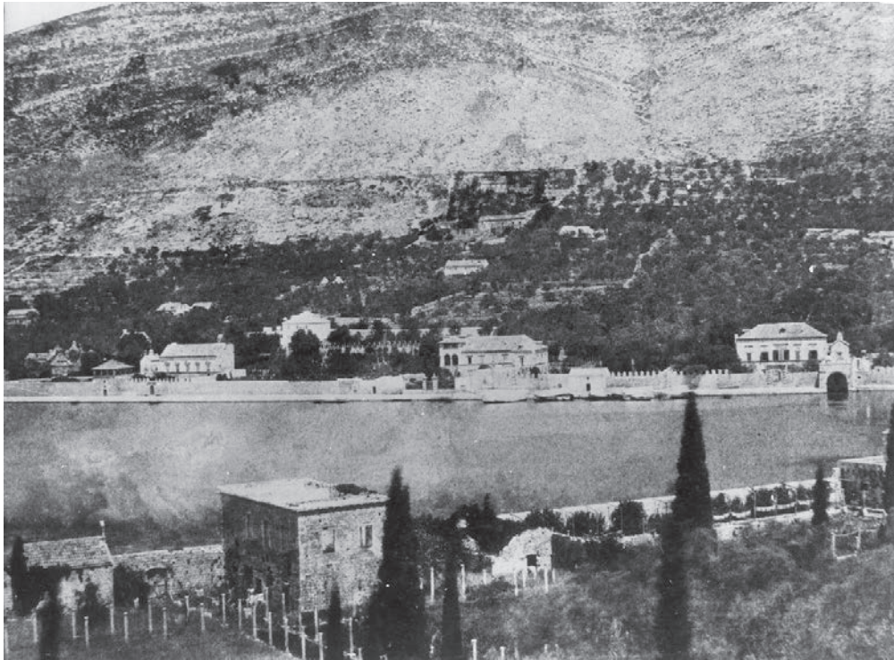
Fig. 6. L'aqueduc en haut de la côte nord du golfe de Gravosa. Au bord de la mer, de gauche à droite, les villas Gondola, Bona et Bona-Gradi à la fin du XIX e siècle (Državni arhiv u Dubrovniku)
