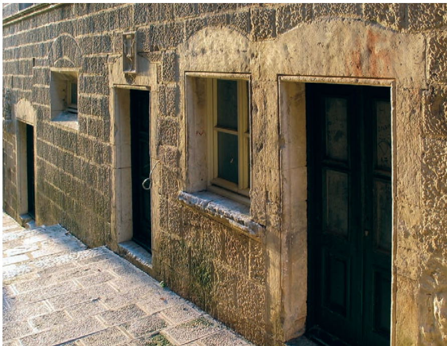
Fig. 4. Korčula. Ground floor of the gothic Arneri palace (south façade). Sl. 4. Korčula. Prizemlje gotičke palače Arneri (južno pročelje).
