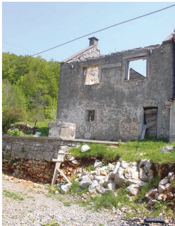
Slika 3: Kuća s jednim ulazom, Alan; snimila M. Rajković; svibanj 2005.
